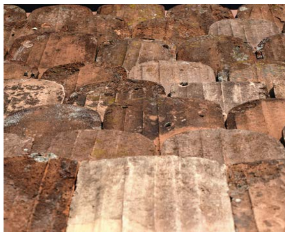
Gebrauchte Bieberschwanzziegel wurden neu verbaut. BILD: DORIS BURGER
