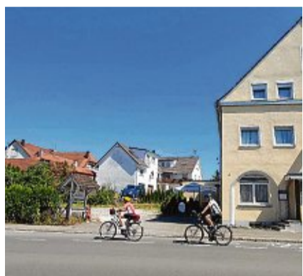
Der Technische Ausschuss hat einen Neubau für eine Seniorengemeinschaft mit Parkplätzen links neben dem Hotel Sonne in Mühlhofen abgelehnt. Begründung: Er füge sich nicht in die Umgebungsbebauung ein. BILD: HOLGER KLEINSTÜCK
