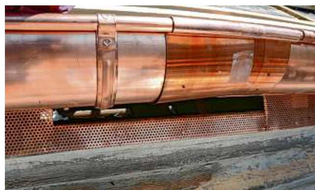
Unter den neuen Dachrinnen erhielt man die alten Einflugschnitten der Fledermäuse.
