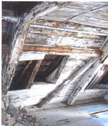
Schicht für Schicht werden die Wände freigelegt und erhalten.
