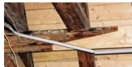
Echtes Zimmererhandwerk: Ein neuer Balken angesetzt an einem alten.
