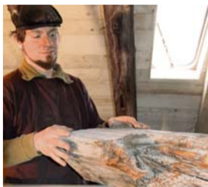
Zimmerermeister Marc Möller zeigt ein morsches Balkenstück, das er im Dachstuhl der „Alten Post“ gegen ein neues ausgetauscht hat.
