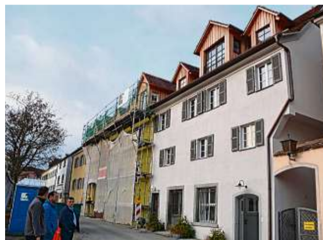
Die Rückseite des sanierten Barockhauses. Derzeit arbeitet das dafür ausgezeichnete Handwerkerteam am Nachbargebäude, das ebenfalls von ihm instandgesetzt wird.
