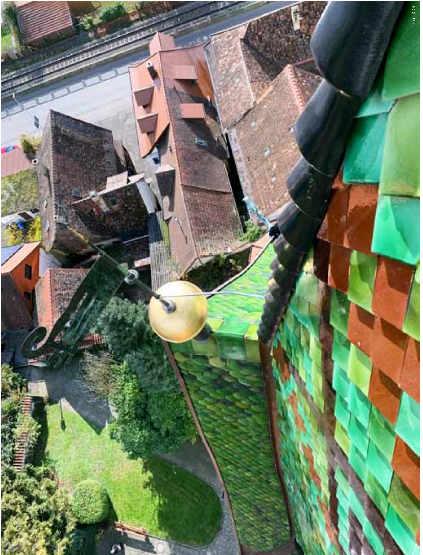
Blick aus der Dachluke Richtung Boden
