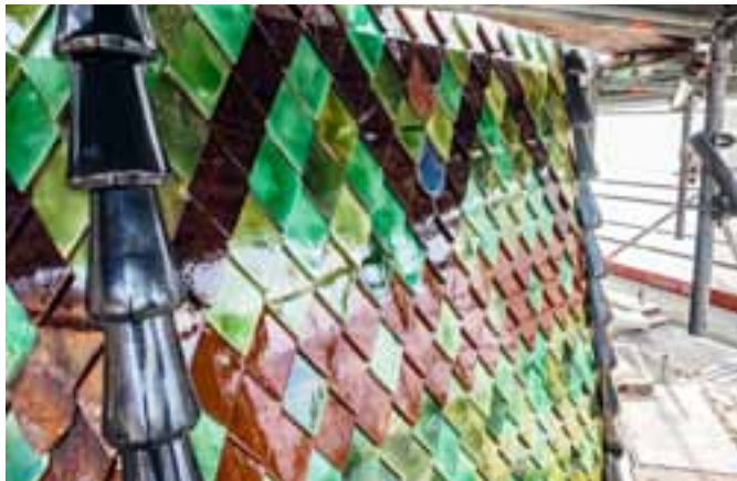
Bewusst wurden die Gratziegel in einem dunklen Farbton gewählt, um die Struktur des Turms noch deutlicher abzubilden.
