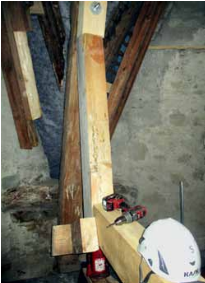
Umfangreiche Holzarbeiten im Inneren des Turms waren nötig, bevor die Deckung abgenommen wurde.
