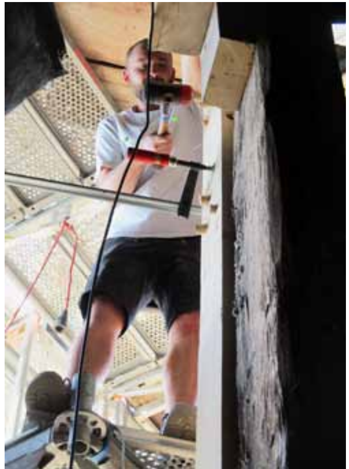
Traditionelle Verbindung mit Holznägeln fixiert
