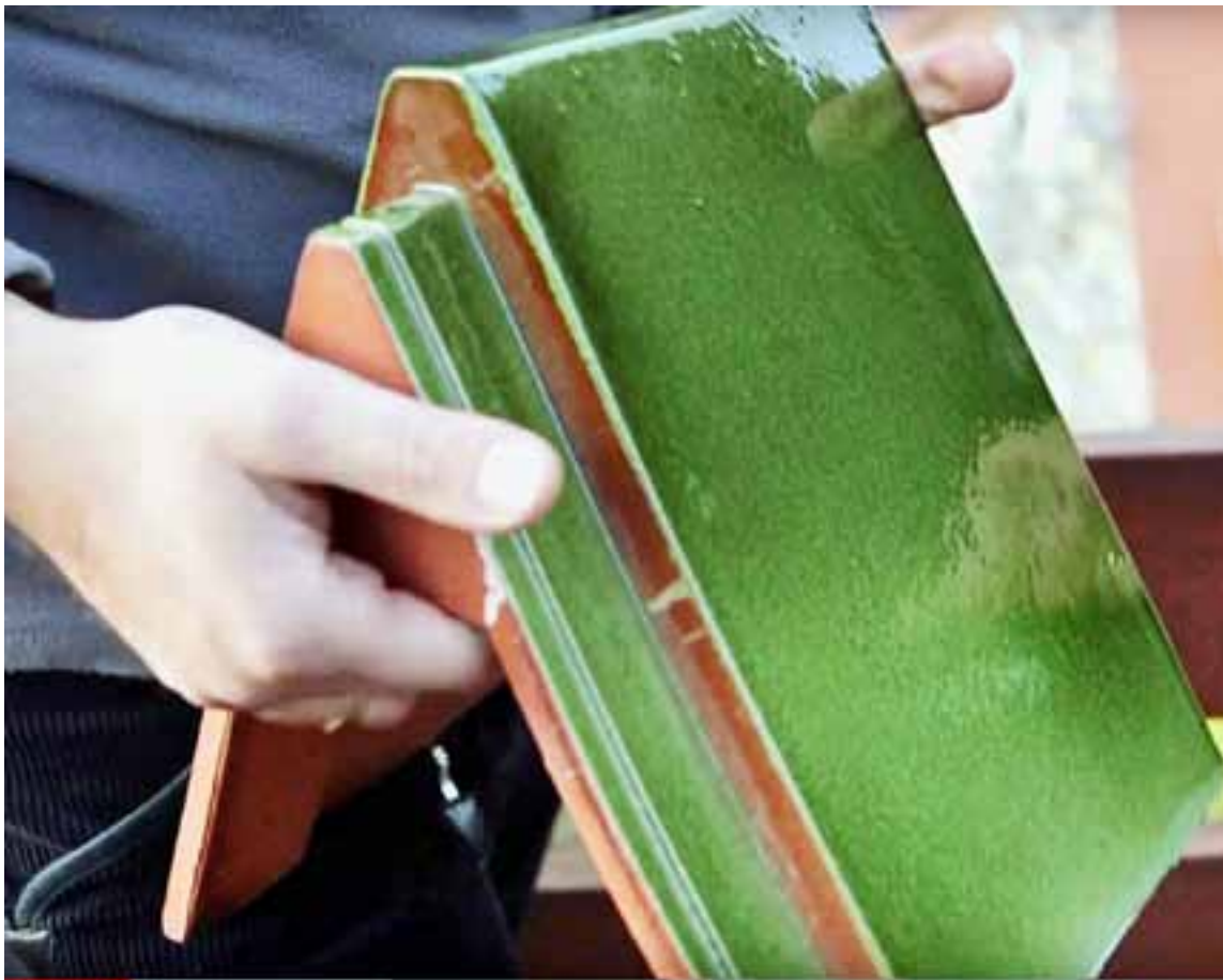
Kostbares Gut: Die eigens angefertigten Firstkappen ermöglichen eine trockene Verlegung des Aufbaus.
