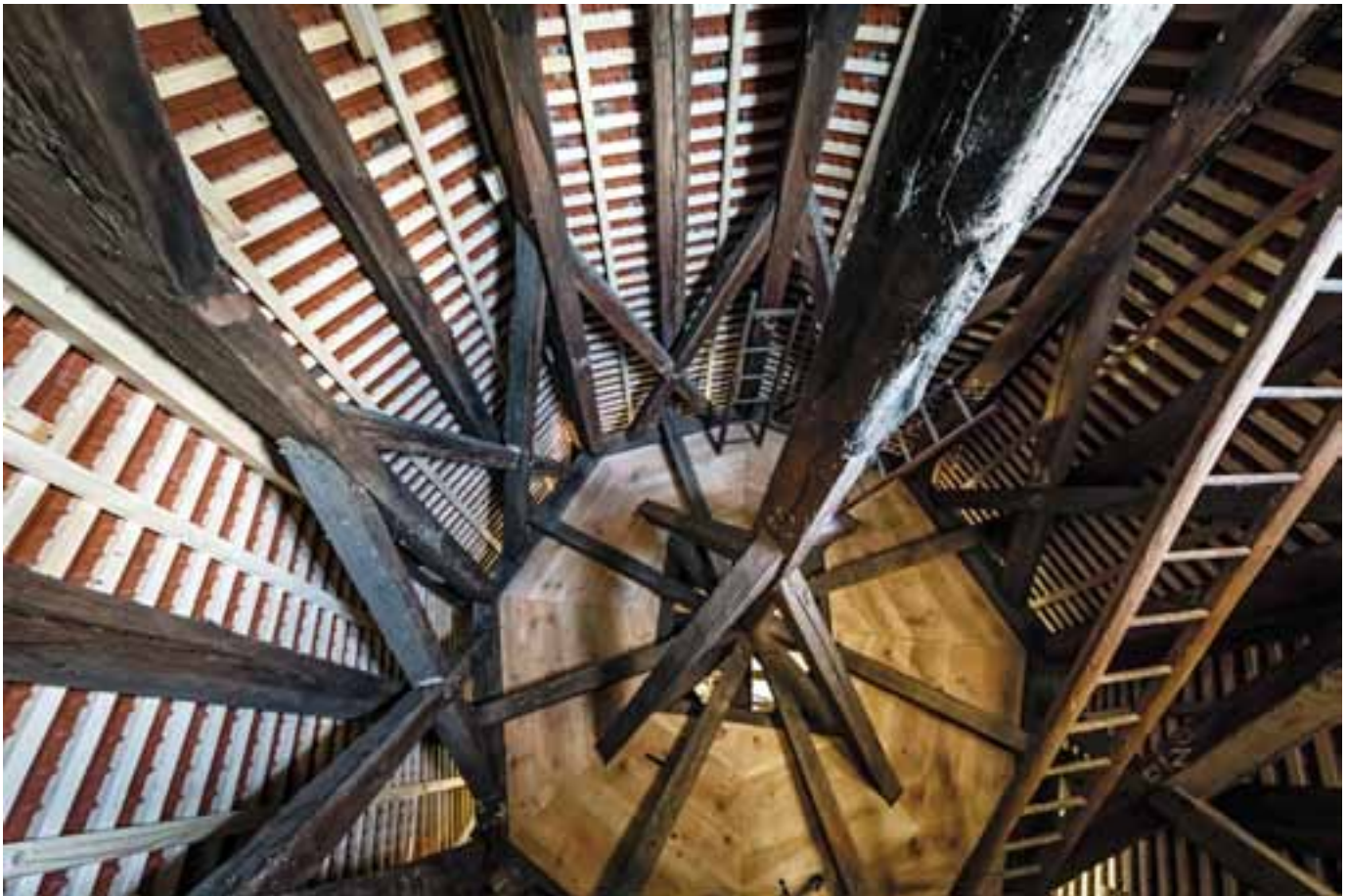
Innenansicht des imposanten Dachtragwerks
