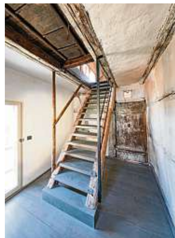
Alt und neu beieinander: Holz und Stahl halten die Treppe.
