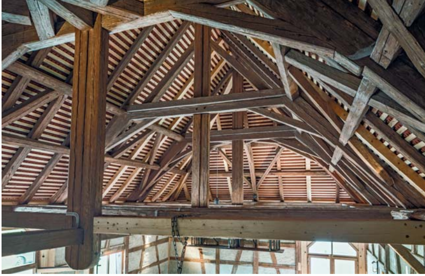
2 Der mächtige Dachstuhl mit seinem Hängewerk hatte es den neuen Eigentümern angetan, hier nach seiner Instandsetzung 2014. Diese Art der Dachkonstruktion ist charakteristisch für Keltergebäude, die für den Torkel oder Kelterbaum hohe und stützenfreie Räume benötigten.
