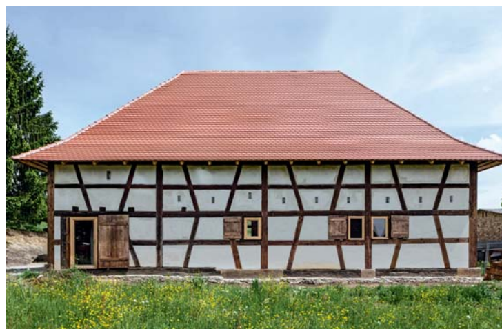
6 Das Torkelgebäude nach der Instandsetzung 2014: Das Dach erhielt eine Deckung mit Dachbibern kräftiger Qualität. Ursprünglich vorhandene und im vermauerten Zustand noch ablesbare Fenster wurden auch an der Westseite reaktiviert. Typisch für die Salemer Torkelgebäude sind die kleinen Öffnungen im oberen Bereich aller Außenwände, die der Querbelüftung dienen. Heute mit Festverglasung ausgestattet, tragen sie weiterhin zur Belichtung der Halle bei.
